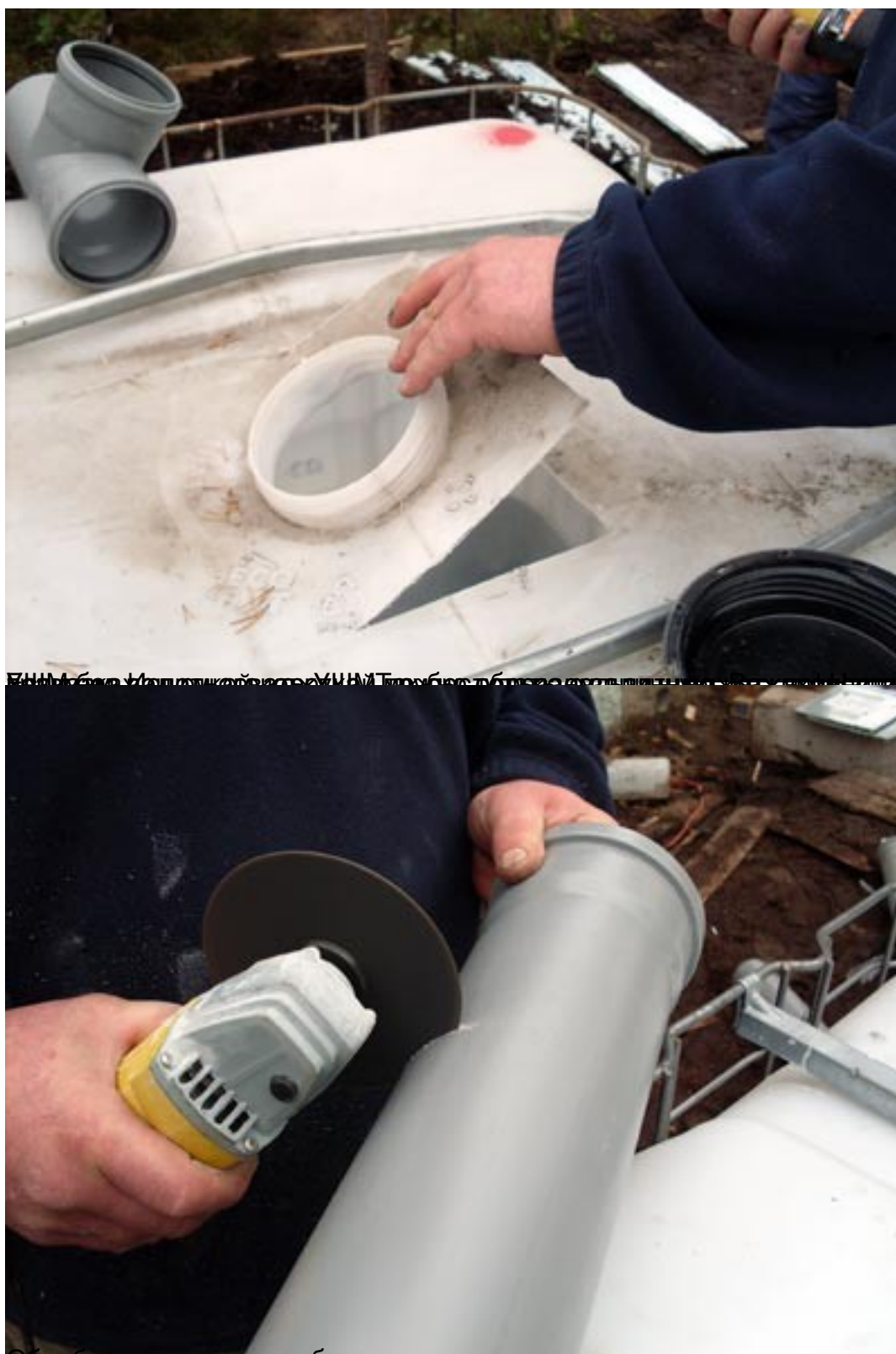
Обрабатываем края трубы.
